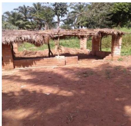
Hangar aménagé pour les cours
